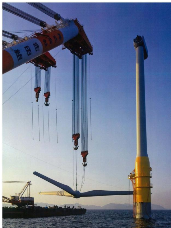
「第 50 号吉田号」(非自航 3, 500T 吊ジブ俯仰式起重機船) : [長崎県枕島沖 浮体式洋上風力発電据付状況]
