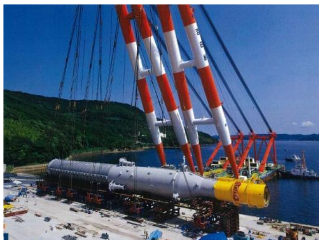
浮体部接合状況
