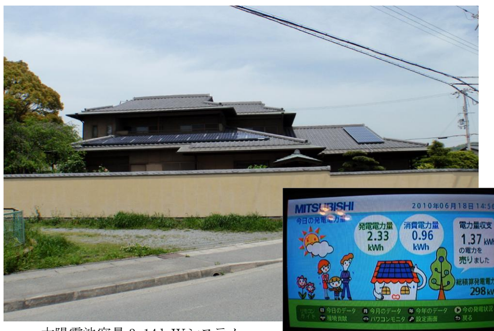
太陽電池容量 3.14 kWシステム
