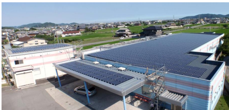
太陽光発電所
